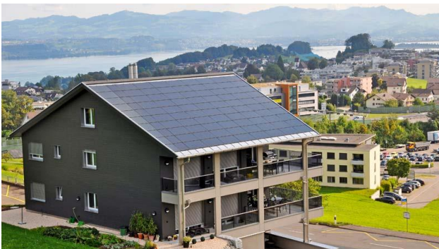
Mehrfamilienhaus mit Photovoltaikanlage
